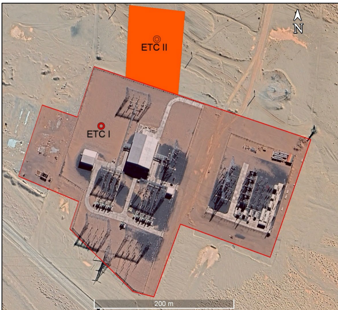
Imagen 01 Ubicación de la nueva Estación Transformadora Cauchari II
